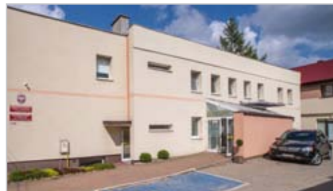
Budynek Powiatowego Centrum Pomocy Rodzinie w Kartuzach
